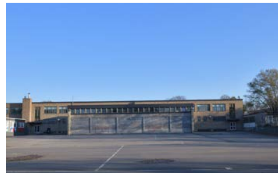
Figure 05. École primaire Gilles-Vigneault annexe vue de la rue Dudemaine
